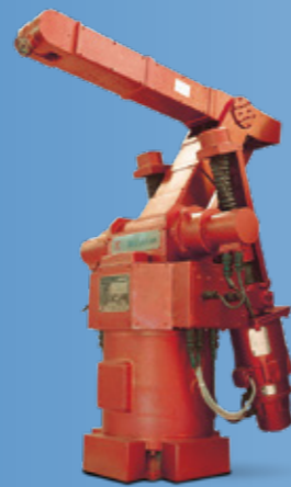
Japan's first all-electric industrial robot "MOTOMAN-L10" 1977年
