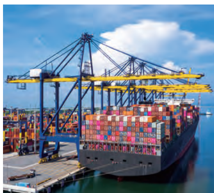
港湾クレーン
